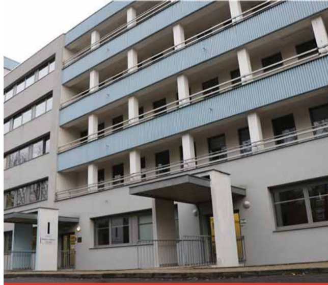
Pavilon „I“ v ústecké Masarykově nemocnici čeká dvouletá generální rekonstrukce.
