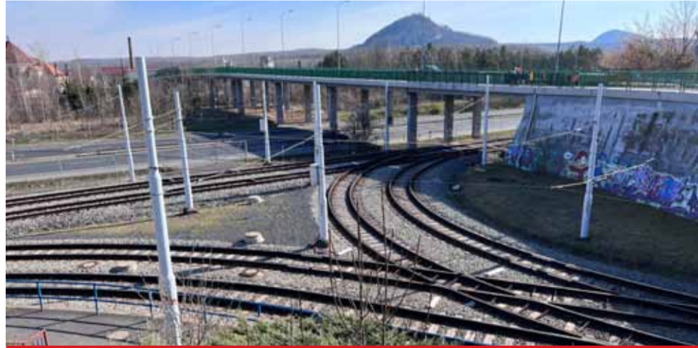
Druhá etapa, která se už intenzivně připravuje, zahrnuje rekonstrukci trati ze Záluží do Mostu, k tak zvanému trianglu poblíž Stovky.
