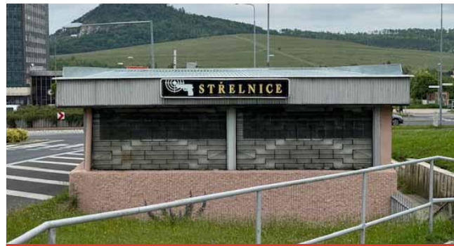
Desítky let fungující střelnice čeká na nového provozovatele už druhým rokem. Jde o unikátní zařízení v celém Česku. Jedná se o krytou halu se vzdáleností střelby na 50 metrů.
