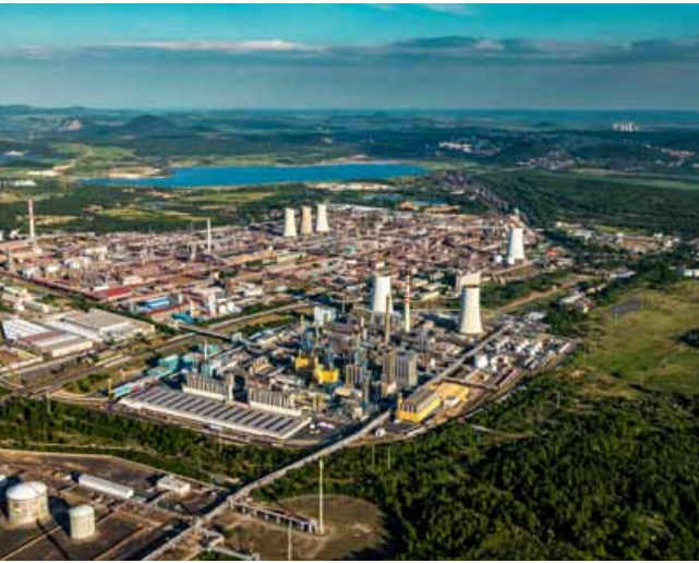
Klíčovými akcemi jsou výmě- na vysokotlakého parovodu, vý- měna vnitřních pater čtyř kolon etylenové jednotky nebo moder- nizace flérovacího systému.
