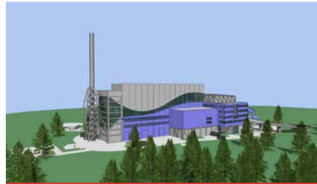
Architekti přišli s myšlenkou, že by nové ZEVO mohlo připomínat tvar a pláštěm obrys ryby. Hlavu tvoří nájezdové rampy pro vozy s odpadem, trup zvýrazňují barevné prvky na opláštění budovy. Komín připomíná rybí ocas.
