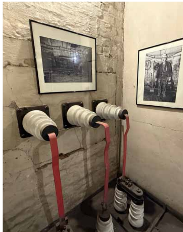
Výstava o minulosti a současnosti Centrumky je instalována v netradičních a o to zajímavějších prostorech bývalé rozvodny.
