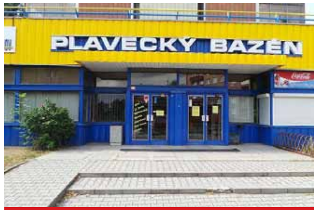
Provoz plavecké haly se kvůli rekonstrukci střechy ukončil o něco dříve. Otevřít by se mělo opět v září.
