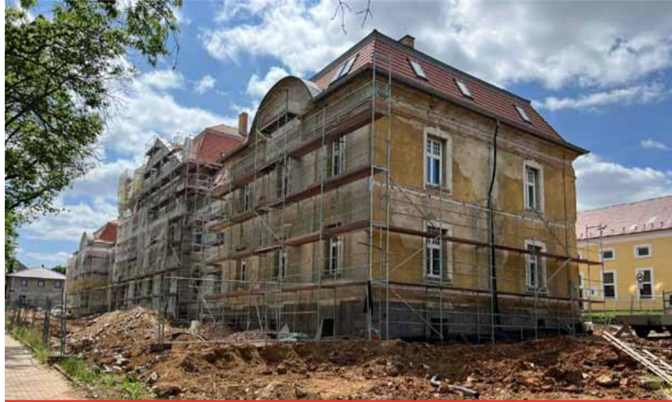
Stavba domova pro nemocné s Alzheimerovou chorobou by měla být hotova ještě letos na podzim.
