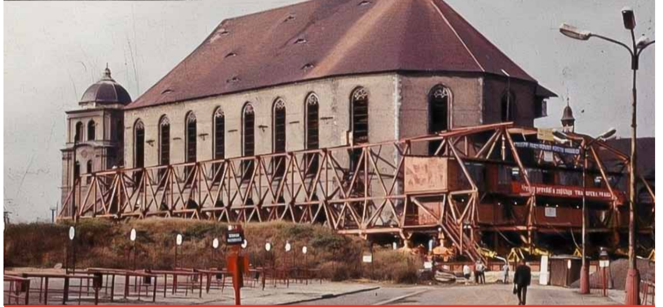
Před padesáti lety, 15. září, sledovala odborná i laická veřejnost na vlastní oči dosud nevidané drama - mostecký chrám se zvedl z pět set let starých základů a dal se do pohybu.
