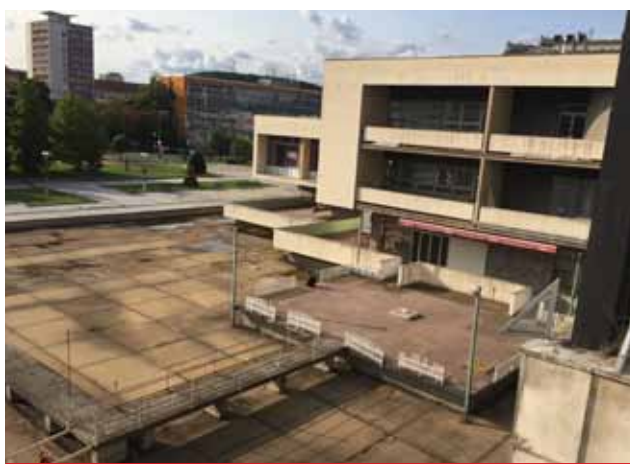
Ikona města Mostu a v poslední době jedna z nejdiskutovanějších staveb se může těšit na zahájení rekonstrukce.
