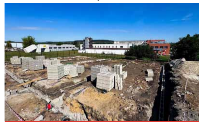
Skleník už se staví, budou s v něm pěstovat hlavně trvalky.
