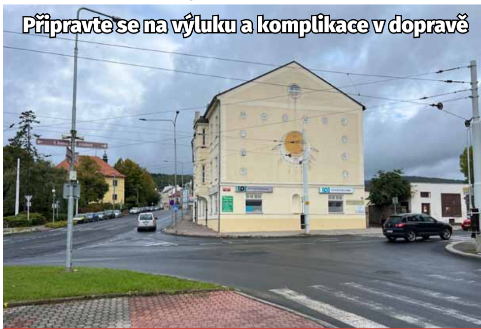
Akce také počítá s úpravou dvou frekventovaných křižovatek, a to na Východě u polikliniky a u slunečních hodin, tedy i bývalého kina Svět. Tady by měla vzniknout nová okružní křižovatka, s předností pro tramvaj.
