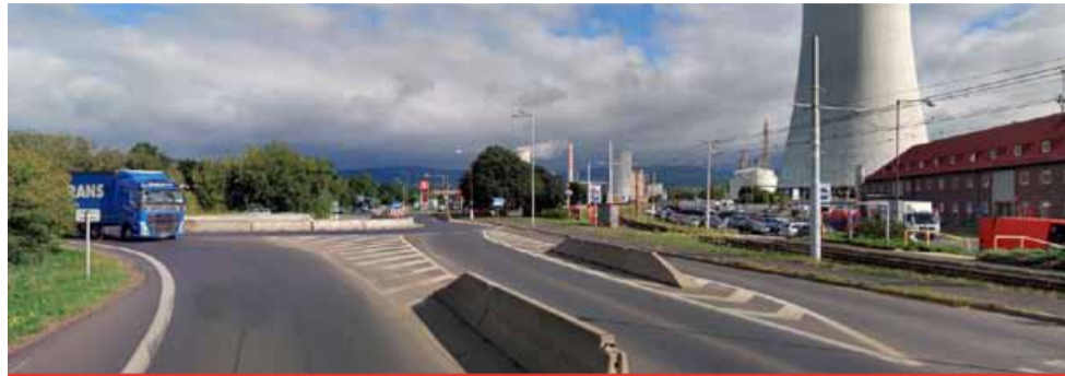
Silnice I/27 mezi Mostem a Litvínovem prochází chemickými závody v Záluží u Litvínova. Stávající dvoupruhová silnice a její dopravní zatížení tak už přesahuje její kapacitu. Proto dojde k jejímu rozšíření na čtyřpruh. Zdroj: www.mapy.cz
