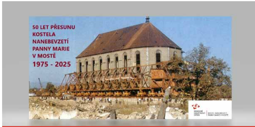
Mostecký kostel letos slaví tři velká kulatá výročí. Padesát let od svého zdvižení a zahájení a ukončení přesunu. Dodnes se tato událost považuje za unikát světového inženýrství.
