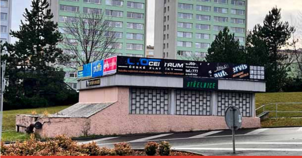
Střelnice u nádraží, která byla vybudovaná v místě bývalého podchodu, je jedinou tunelovou střelnicí se třemi střeleckými stavy v okolí Mostu s popojezdem do 50 metrů. Město tuto střelnici nyní nabízí k pronájmu.
